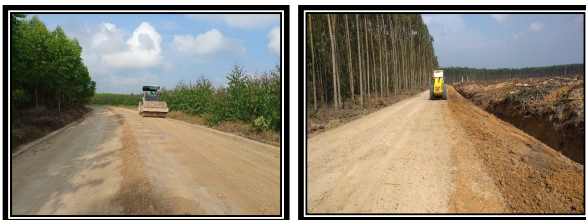
Gambar 1. Perawatan Jalan Utama & Pembangunan Over flow
