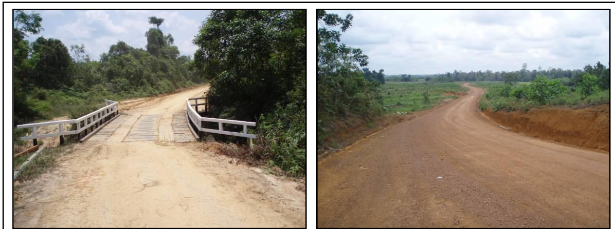
Gambar III-1. Pembangunan sarana jalan dan jembatan di areal PT FI
